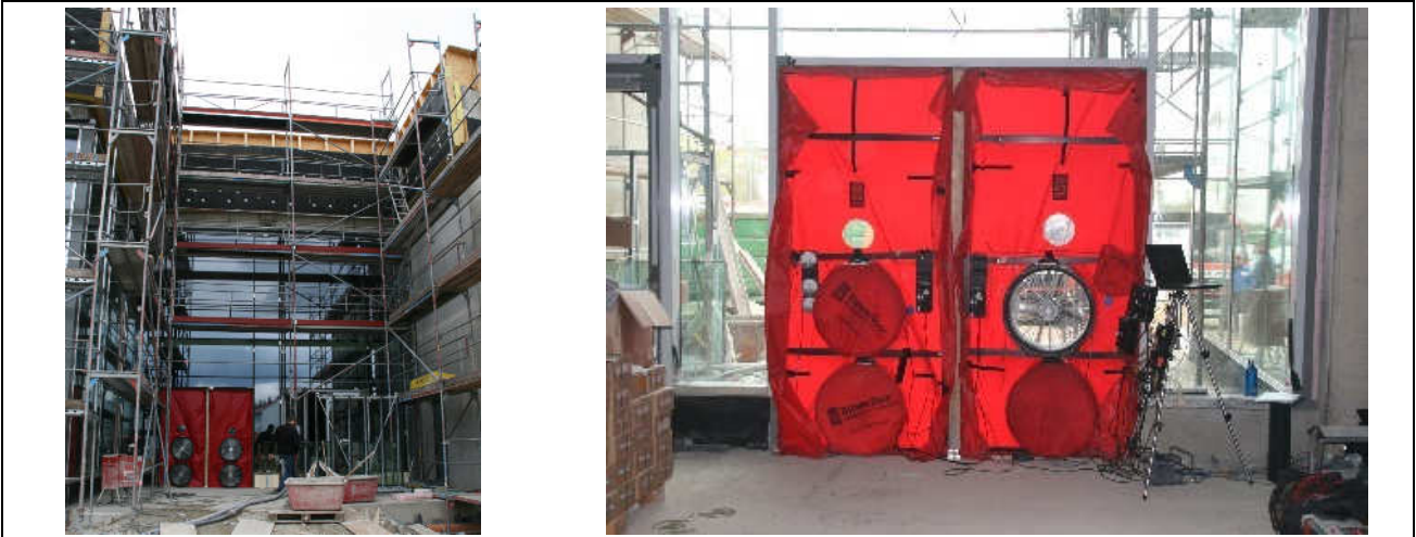
Abbildung 30: Luftdichtheitsmessung: Die Ventilatoren wurden im Bereich der Eingangstüren eingebaut. Für die Messung der Luftdichtheit wurde trotz des großen Innenvolumens nur ein Ventilator benötigt
