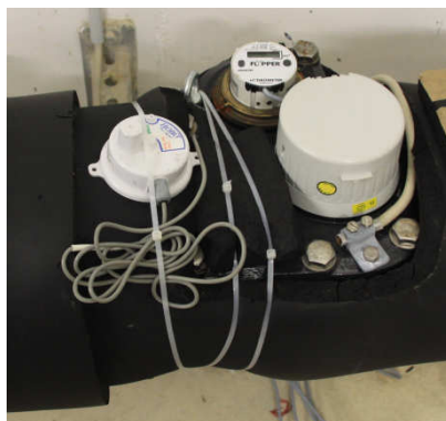
Abbildung 11: Temperatur-Datenlogger zur Aufzeichnung der Kaltwasser-Temperatur (links), (Rechts befindet sich die Hauptwasseruhr)
